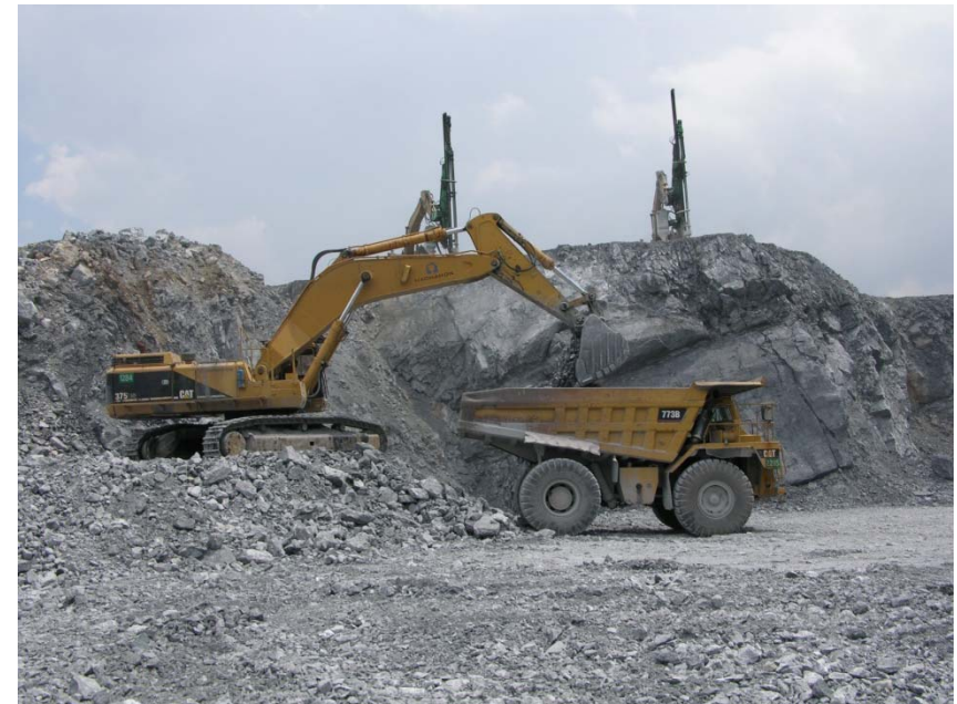
Lhok Nga open cut quarry, Lafarge, Indonesia
