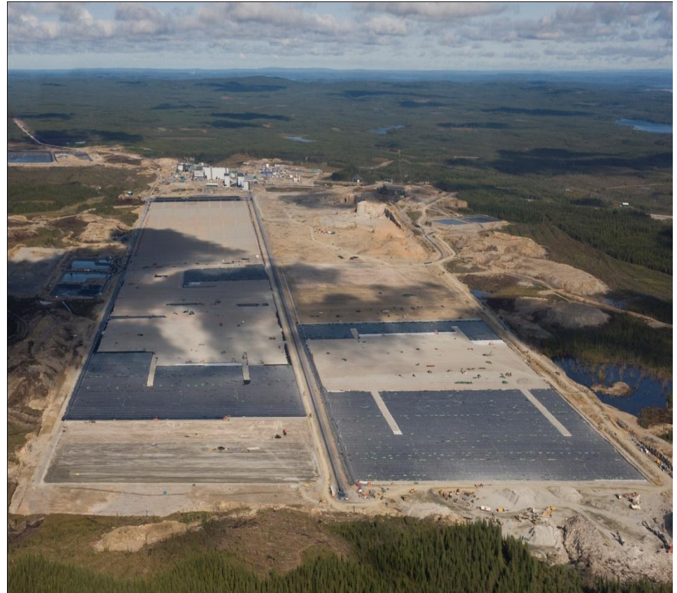
Leachpad – Talvivaara, Finland
