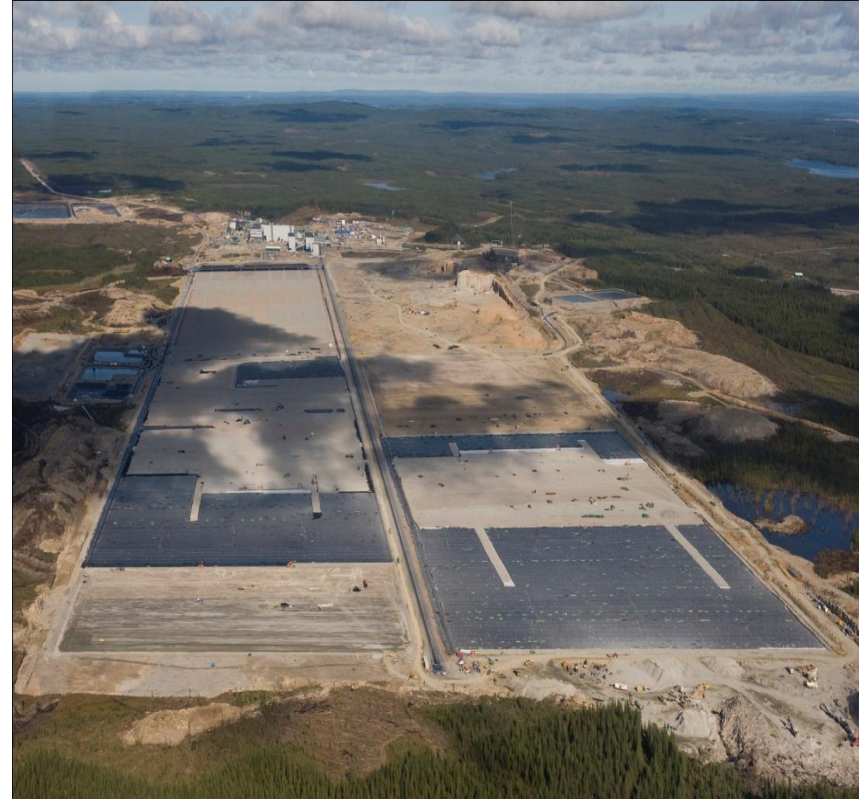
Leachpad – Talvivaara, Finland
