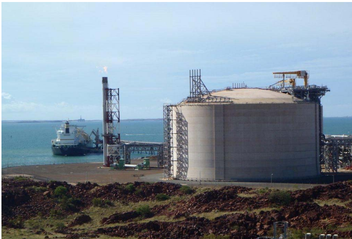
The LNG vessel 'Ebisu' offloading the commissioning cargo at the Pluto LNG Foundation Project, January 2012. The LNG is used to cool down the LNG tanks and LNG transfer lines in preparation for LNG processing.
