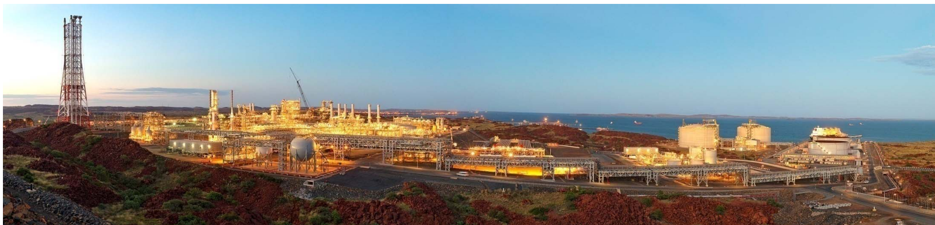
The Pluto LNG Plant
