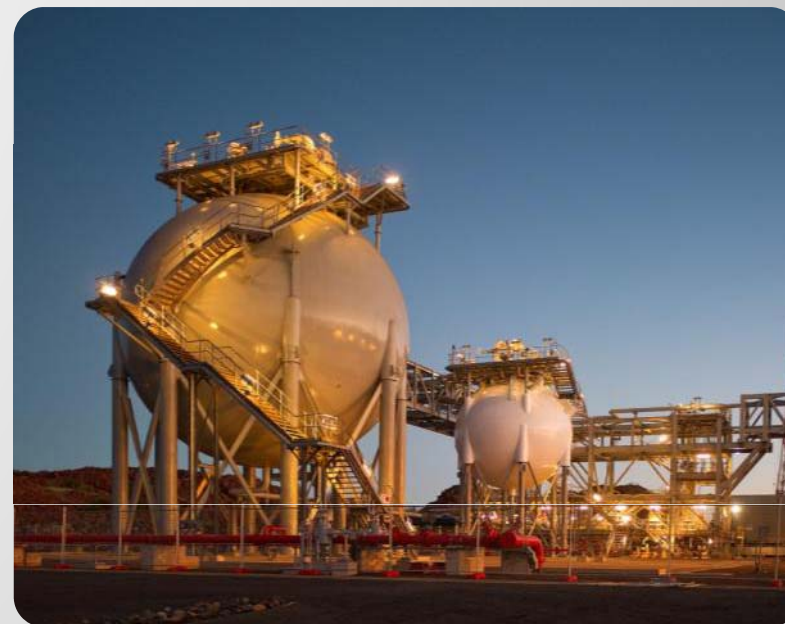
Pluto LNG plant
