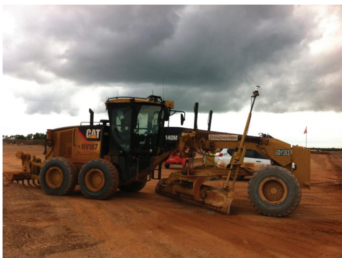
Caterpillar road grader GD1363 - Ichthys LNG Project (Inpex JV)
