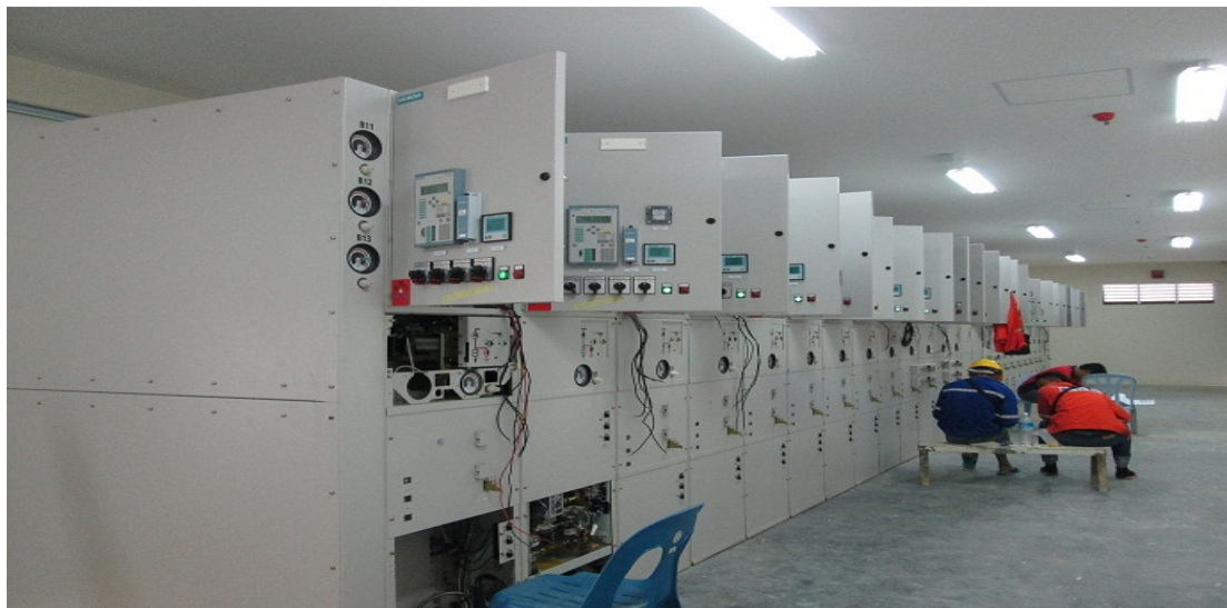
Wiring Check for GIS Switchgear
