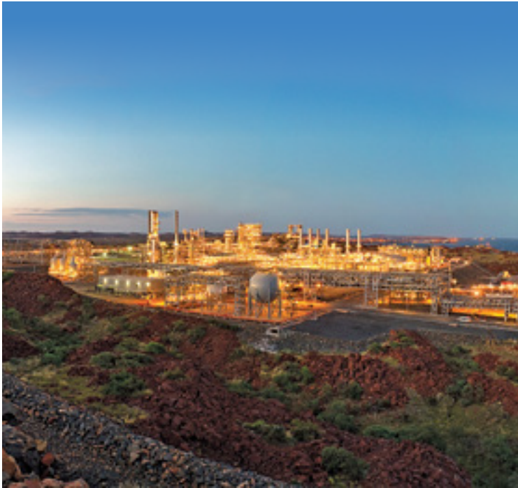
Image - Pluto LNG Plant
