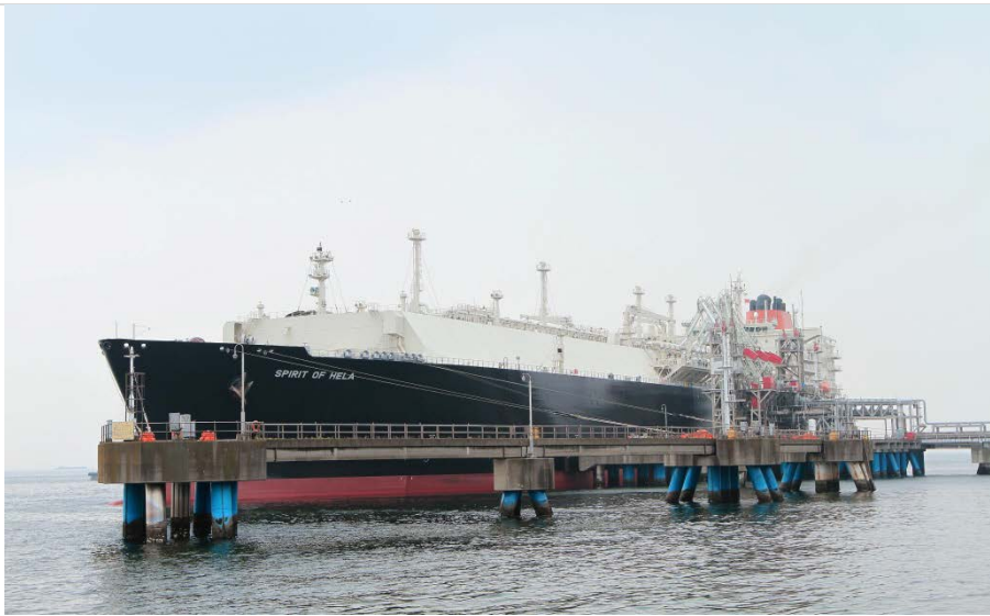
PNG LNG Project delivers first LNG cargo to Japan, June 2014
