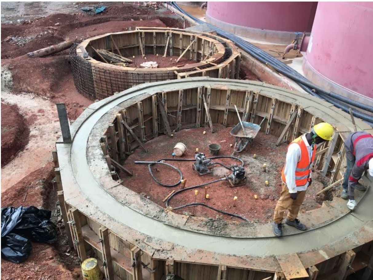
Figure 3: Project 85 - Initial concrete pour
