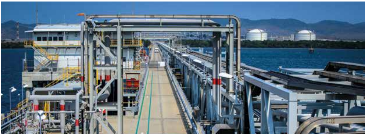
PNG LNG Project jetty near Port Moresby, PNG.
