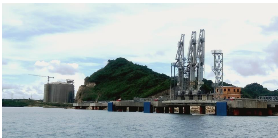
Erection of LNG Loading Arms
