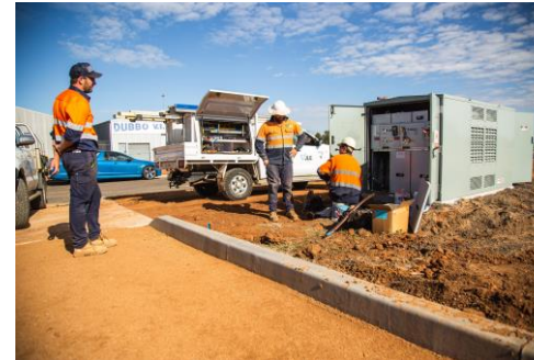
JLE HV install
