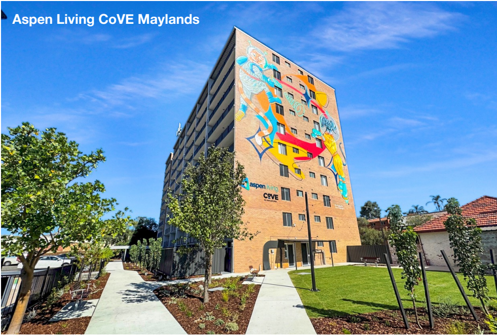
Aspen Living CoVE Upper Mount Gravatt
